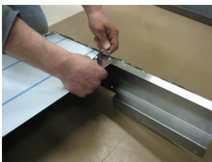
18. Kiinnitä kansilevy ja ohjainlevy kaulukseen, jätä keskimäinen ruuvi asentamatta
