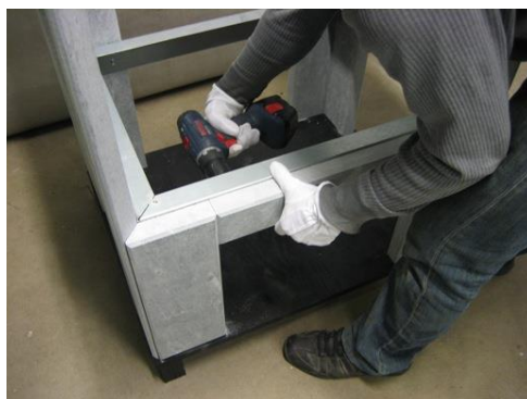
5. Alaetukiven kiinnitys keskikehykseen
