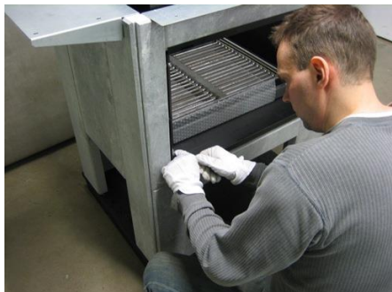
13. Asenna luukun adapteri grillisydämeen
