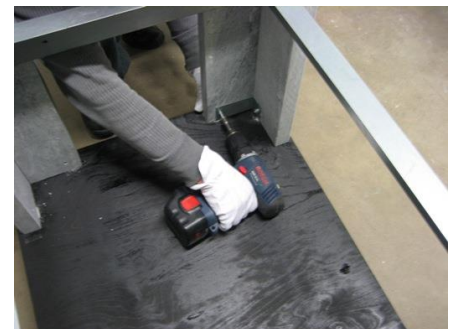
3. Etukulmakivien asennus ja alatuen kiinnitys
