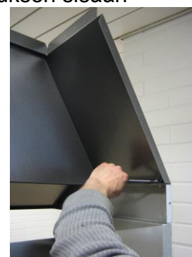
20. Nosta kartiohuuva kauluksen päälle ja kiinnitä sisäpuolelta, muista kiinnittää etukannen keskiruuvi, kiinnitä lopuksi huuvin takalevy
