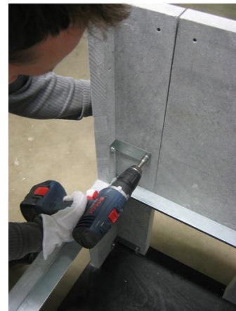
6. Etusivukivi kiinnitetään pitkään etukulmakiveen
