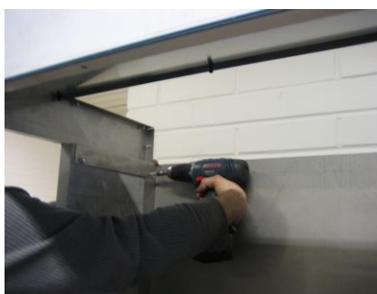
19. Nosta esikoottu kaulus sivukivien päälle ja kiinnitä kivien yläreikiin
