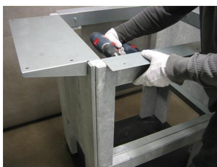
11. Etuyläkiven asennus. Tarkista kiven saumat ja kiristä kaikki ruuvit.
