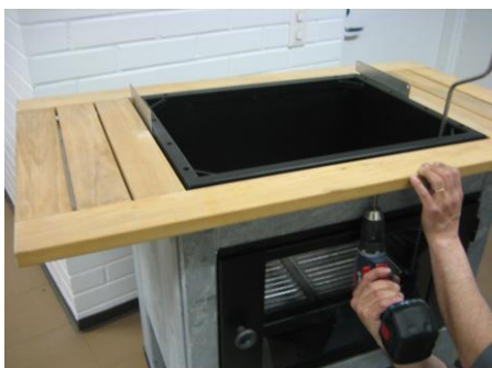
15. Aseta työtason osat kuvan mukaisesti paikoilleen
