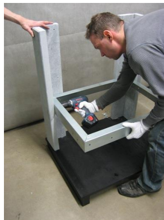
2. Toisten takakulmakivien asennus
