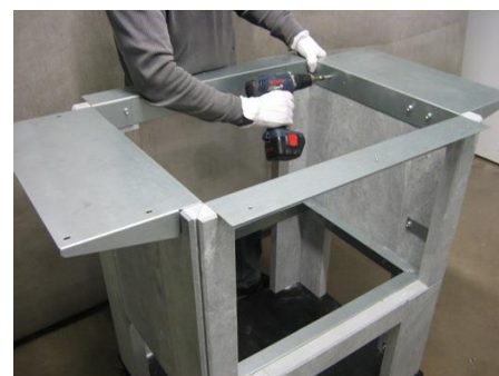
9. Asenna yläkehysten osat paikoilleen ja kiinnitä ruuveilla paikoilleen, muista yläkiven kiinnityslevyt
