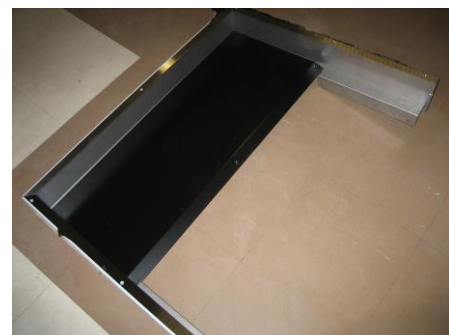
17. Aloita huuvin koonta asettamalla ohjainlevy kauluksen sisään
