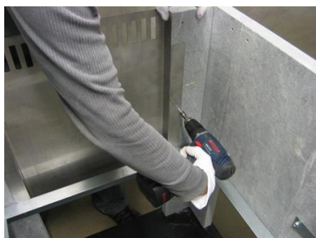
8. Kiinnitä takalevy kahdella ruuvilla
